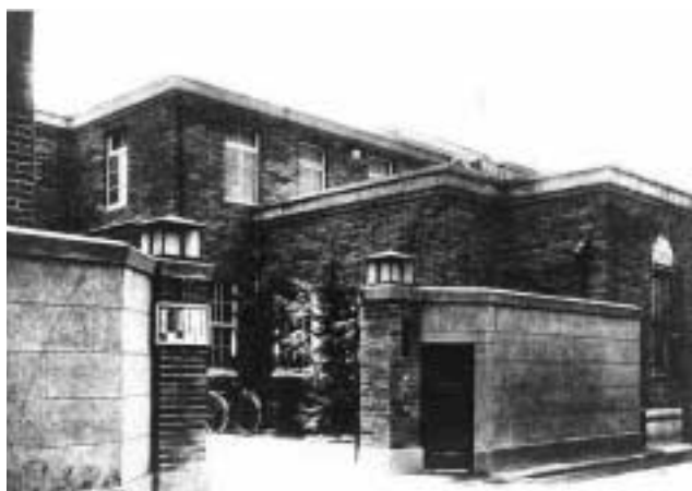
写真：第二次本店・工場
